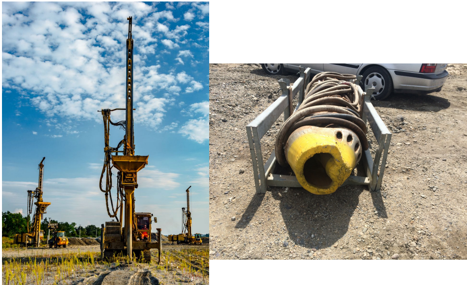
Figura. 6. Maquinaria de ejecución de columnas de gravas por el método de vibrosustitución.
