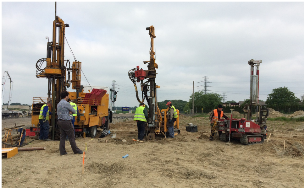
Figura. 9. Sondeos de rotación (y SPT), DPSH y CPTU realizados en las columnas.
