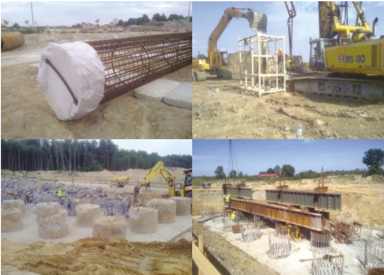
FIGURA 2. Fotografías del proceso de ejecución y ensayo de los pilotes.
